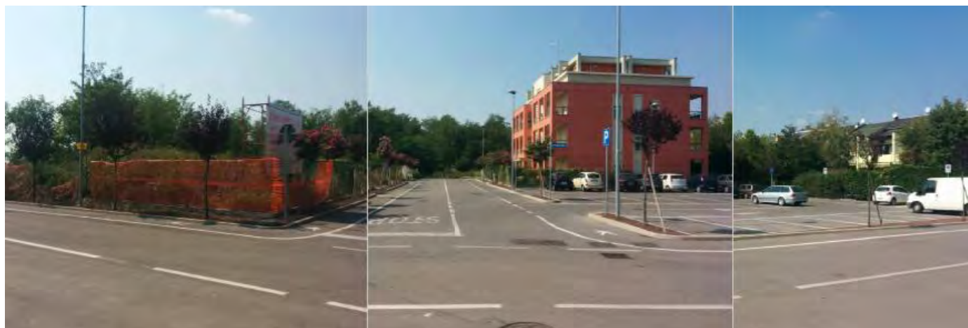
Figura 3.1-1 – palazzina e parcheggio lato ovest
